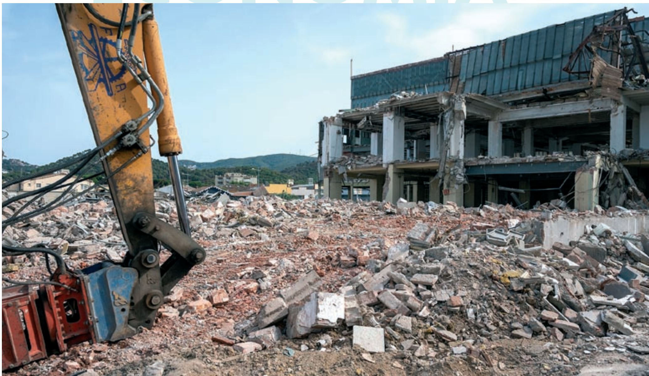
Les naus històriques de Derbi, que va comprar Piaggio, s'estan enderrocant aquests dies. L'espai l'ocuparà un aparcament per a camions del gegant de la logística Amazon
