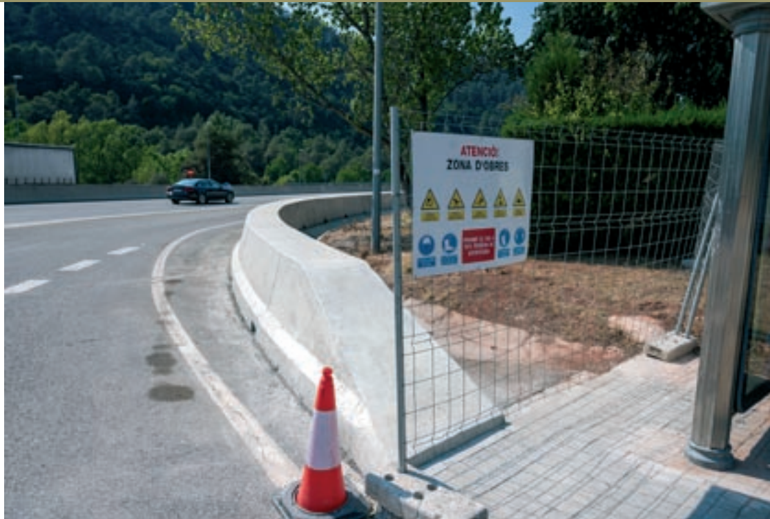
L'actuació a Tagamanent on s'han completat els murs de formigó al damunt dels quals es col·locaran les pantalles
