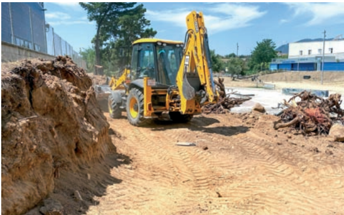
La instal·lació estarà al costat mateix de la comissaria de districte dels Mossos d'Esquadra a Caldes
