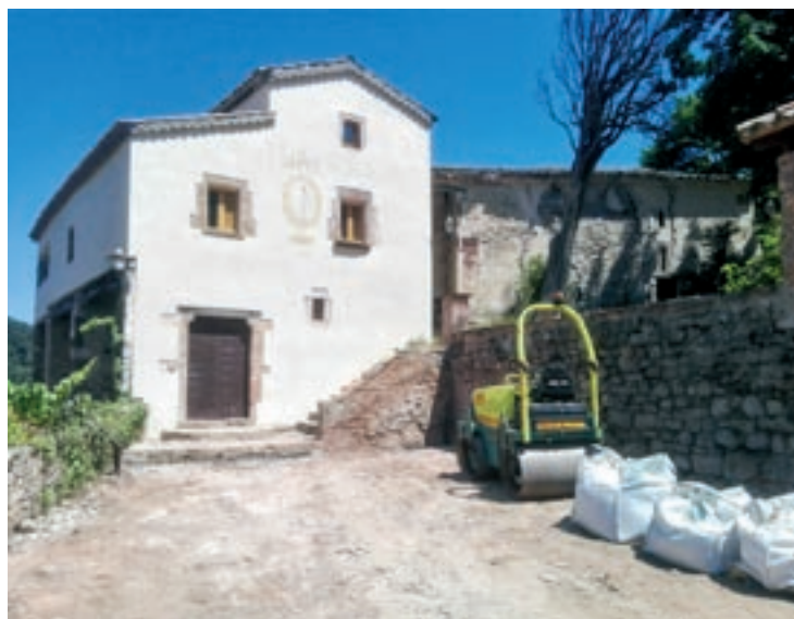
Una imatge de la masoveria, ja rehabilitada
