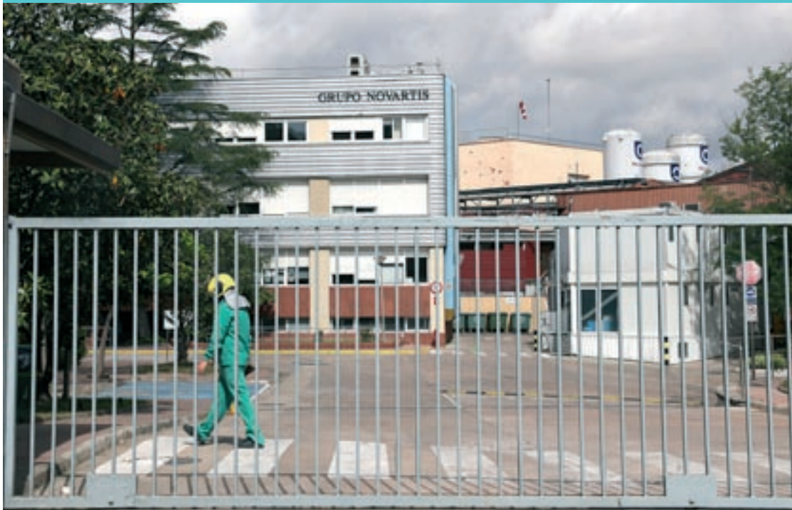
La planta de Sandoz, al peu de la carretera de Granollers a Cardedeu, en una imatge d'aquest mes de juny
