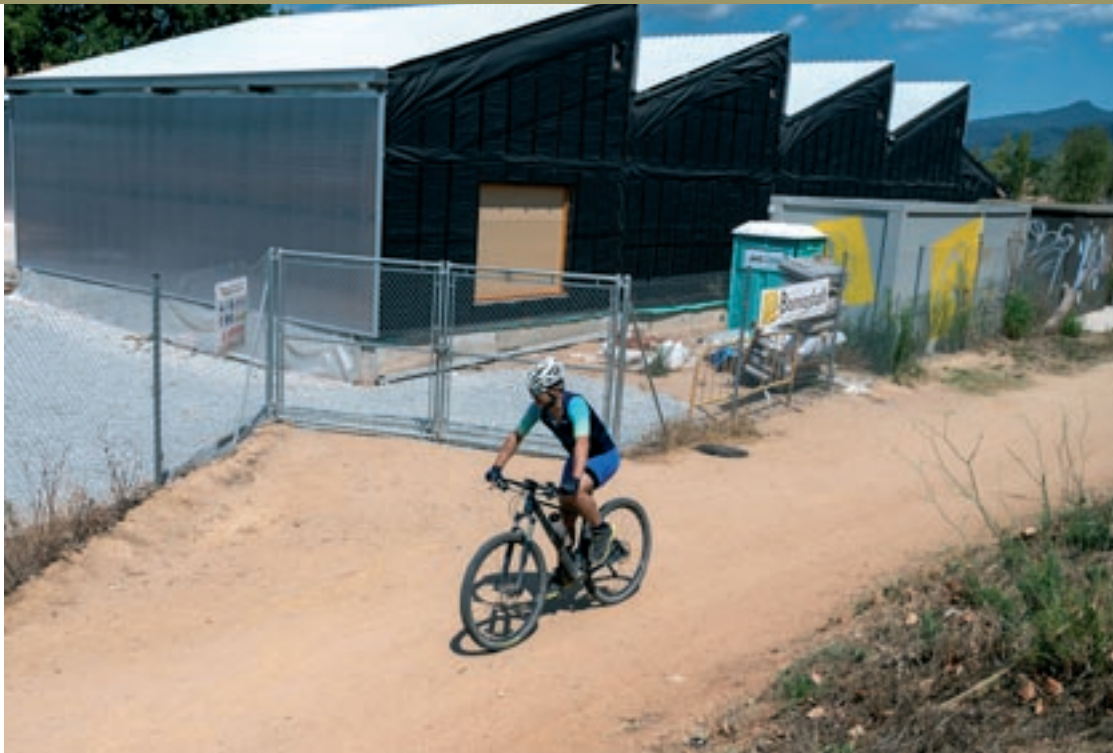
L'edifici de la nova Aula de natura al parc del Falgar, a Llerona, va prenent forma
