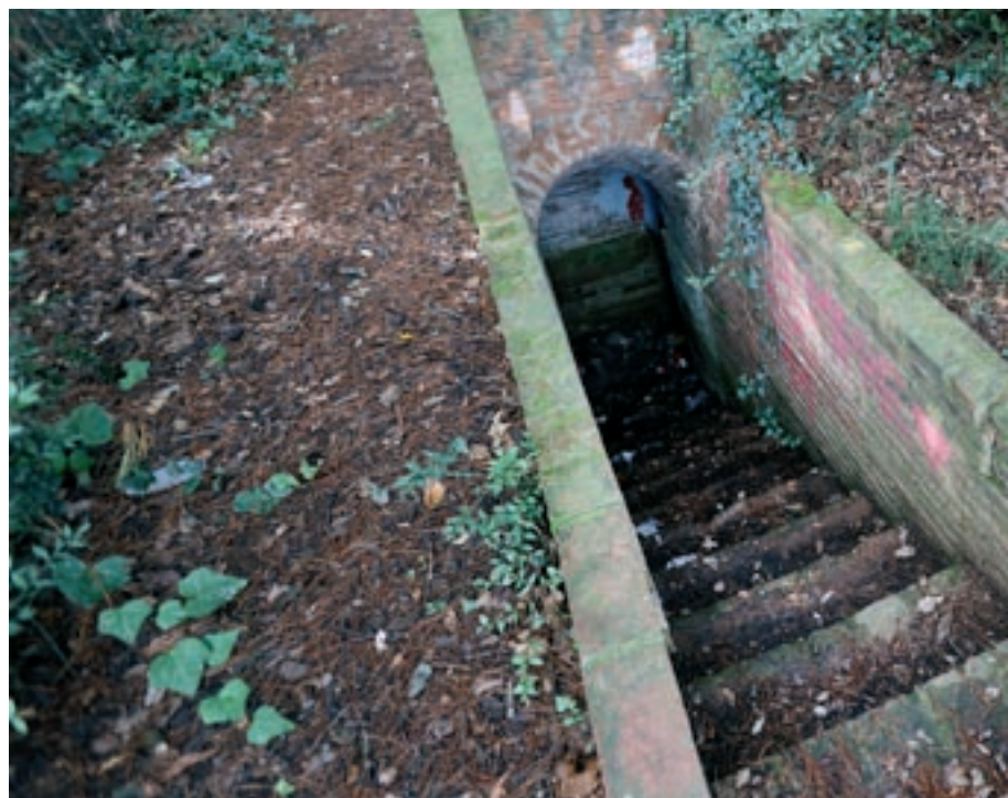
Un dels refugis que formaven part de les instal·lacions de l'aeròdrom que hi havia a Alfou, a cavall dels dos municipis.
