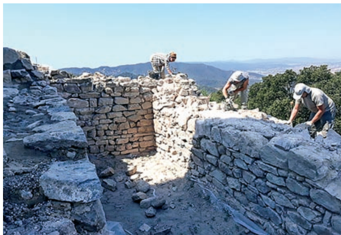
L'actuació, que s'està fent aquest estiu, es concentra en les estructures descobertes entre el 2019 i el 2020
