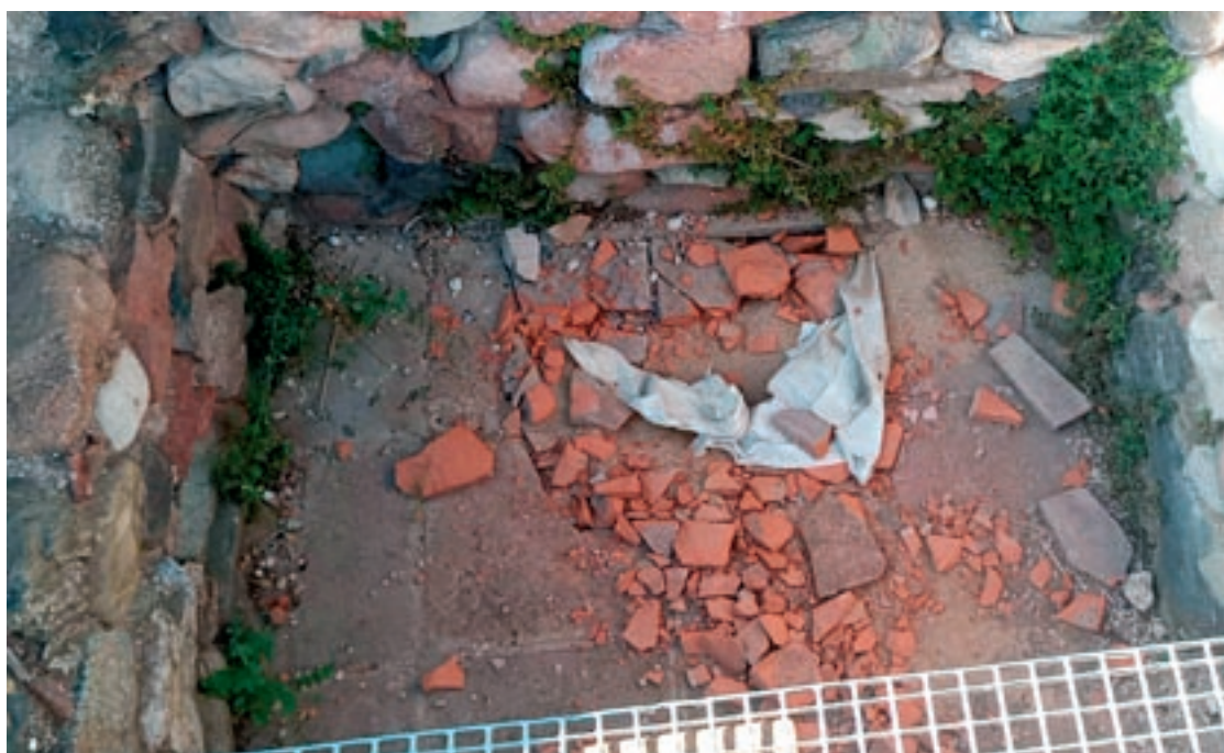
Imatge dels desperfectes que va ocasionar la bretolada al jaciment arqueològic de Can Terrers
