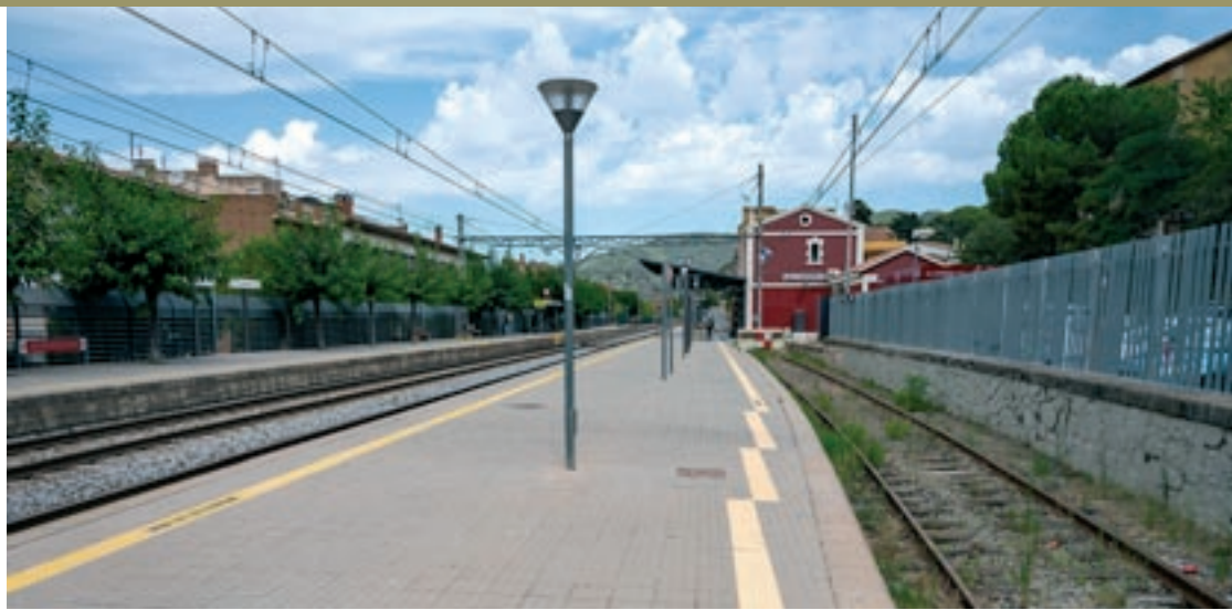
La via 4 de l'estació de la Garriga, a la dreta de la imatge, quedarà anul·lada per les obres de reforma
