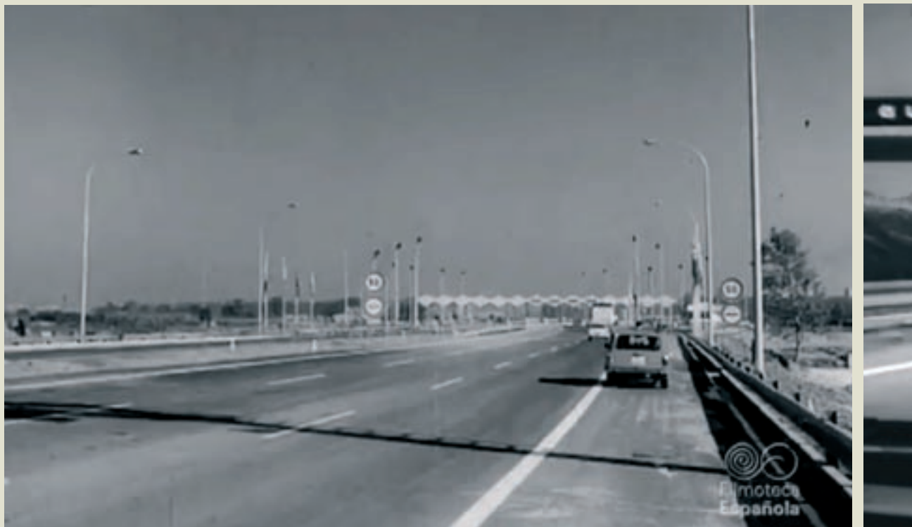
La construcció i inauguració dels primers trams de l'autopista A-19, l'Autopista del Mediterrani, va ser àmpliament difosa pels mitjans de...
