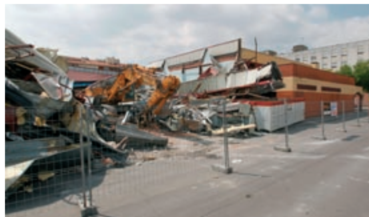
Obres d'enderroc de l'antic edifici, l'any 2010
