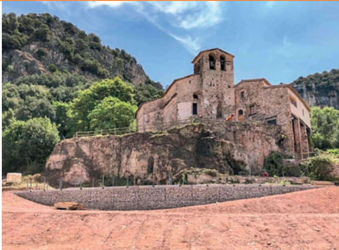
El conjunt monumental d'Aiguafreda de Dalt, amb l'aspecte que ofereix després de les darreres obres
