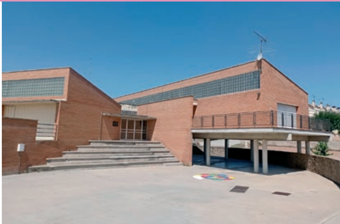
Edifici de l'escola Els Roures, on es faran obres per traslladar-hi la llar d'infants municipal
