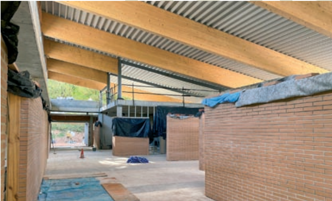
Les obres de l'escola de Muntanyola van començar al gener i es preveu que acabin a finals d'any
