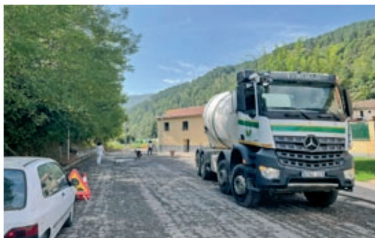
La pavimentació s'ha iniciat per l'avinguda de la Creu
