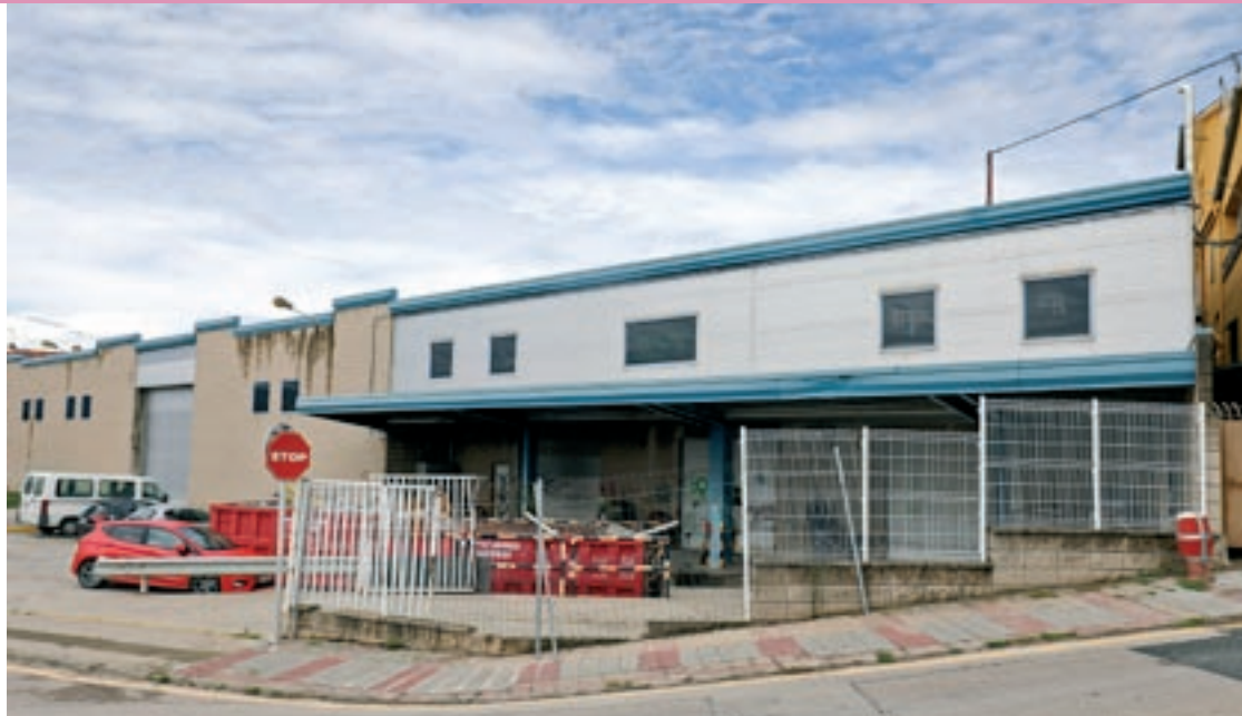
Les obres d'adequació de l'antiga nau de Cata han començat aquesta setmana
