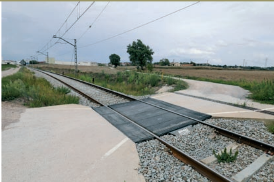
L'actual pas a nivell sense barrera, que es desplaçarà en direcció a la fàbrica de Monells, al fons, degudament protegit
