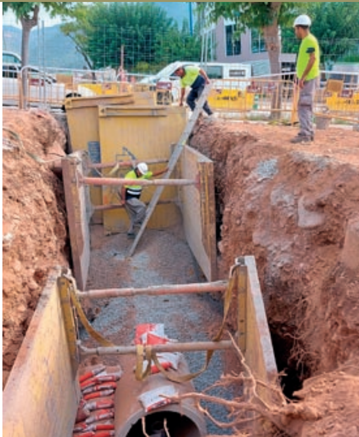
Les obres del clavegueram del carrer Montserrat aquest dimecres
