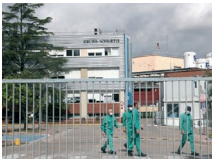
Instal·lacions de Sandoz a les Franqueses
