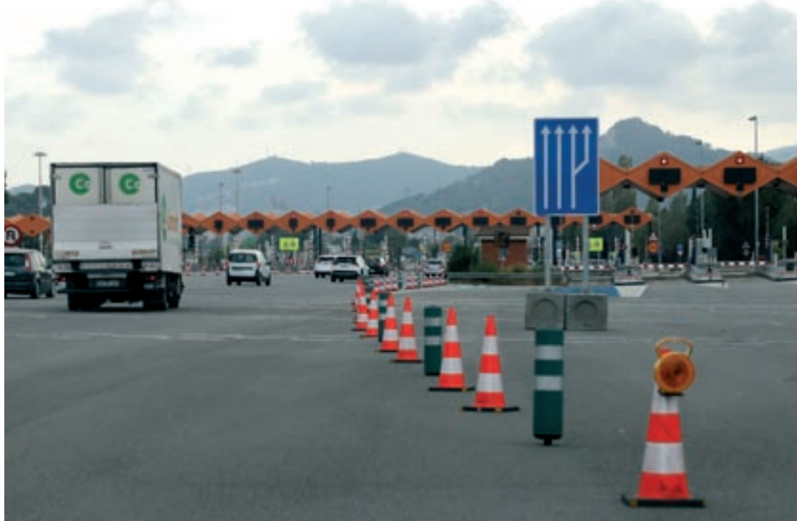
El trànsit ara ja passa per les cabines situades als laterals de la platja del peatge. Això permetrà treballar al centre
