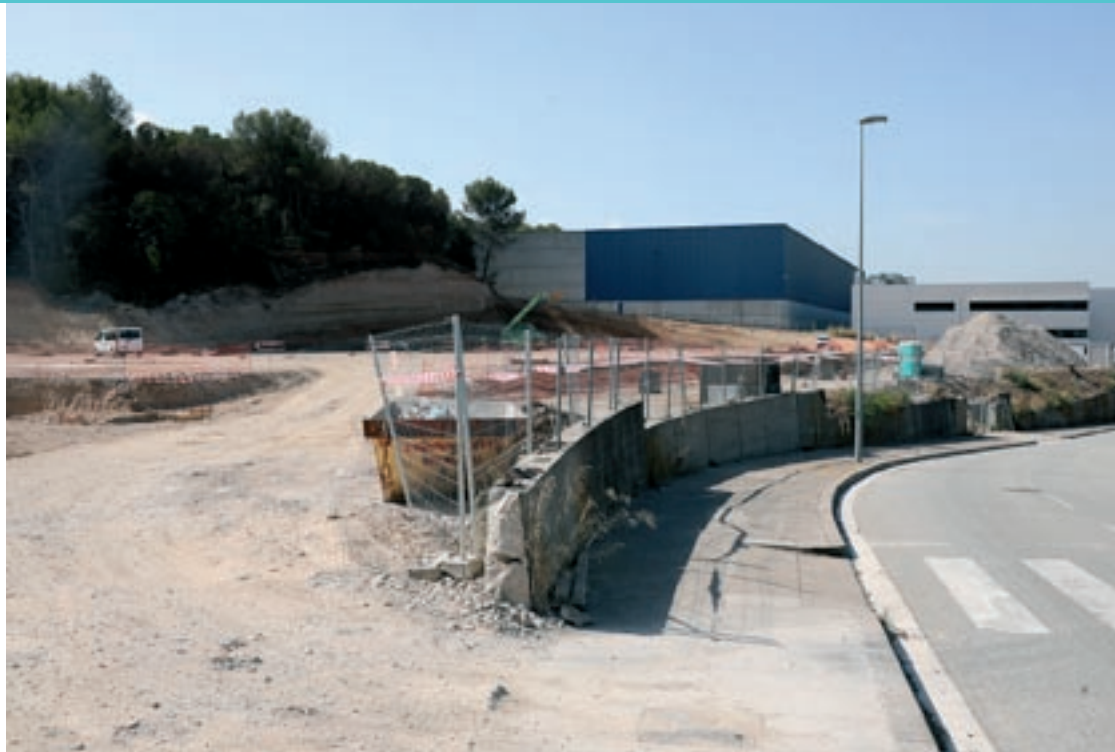
L'espai que ocupava l'antiga fàbrica de perfumeria Dana, un cop enderrocades les instal·lacions
