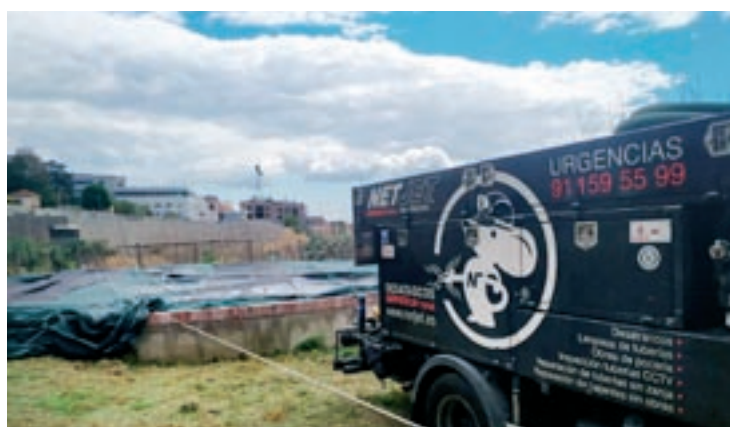
Una empresa especialitzada treballa per retirar el combustible vessat
