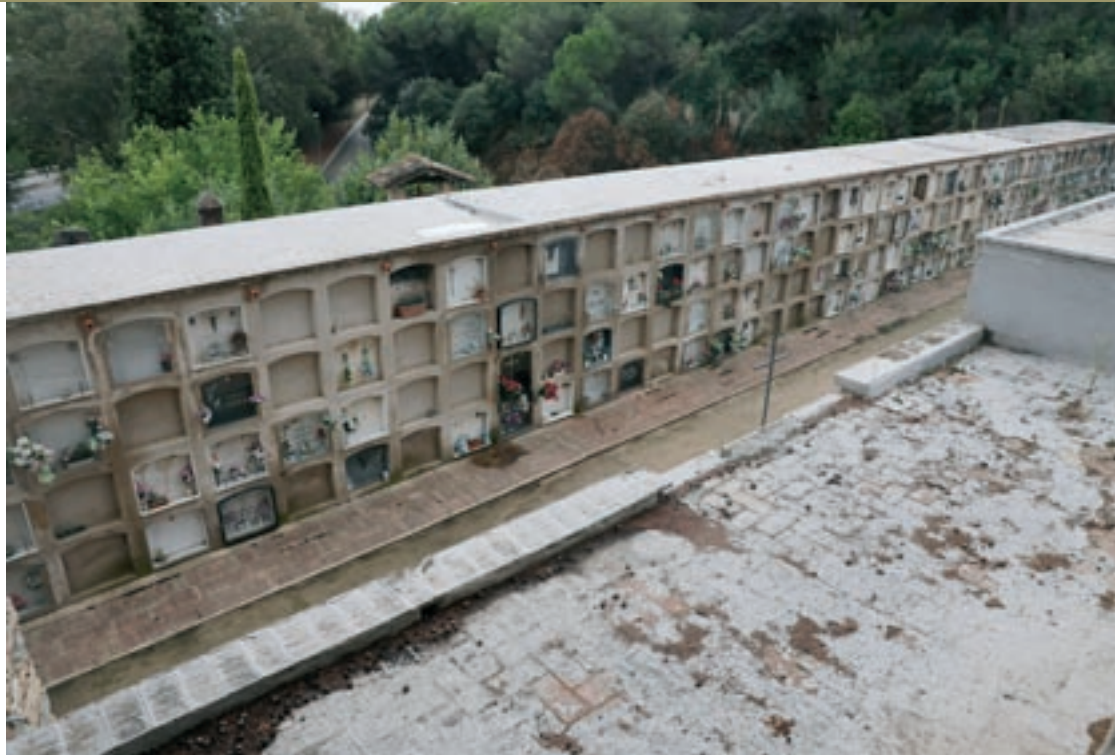
S'actuarà a les cobertes per evitar que l'aigua de la pluja acabi malmetent les façanes dels blocs de nínxols com passa ara
