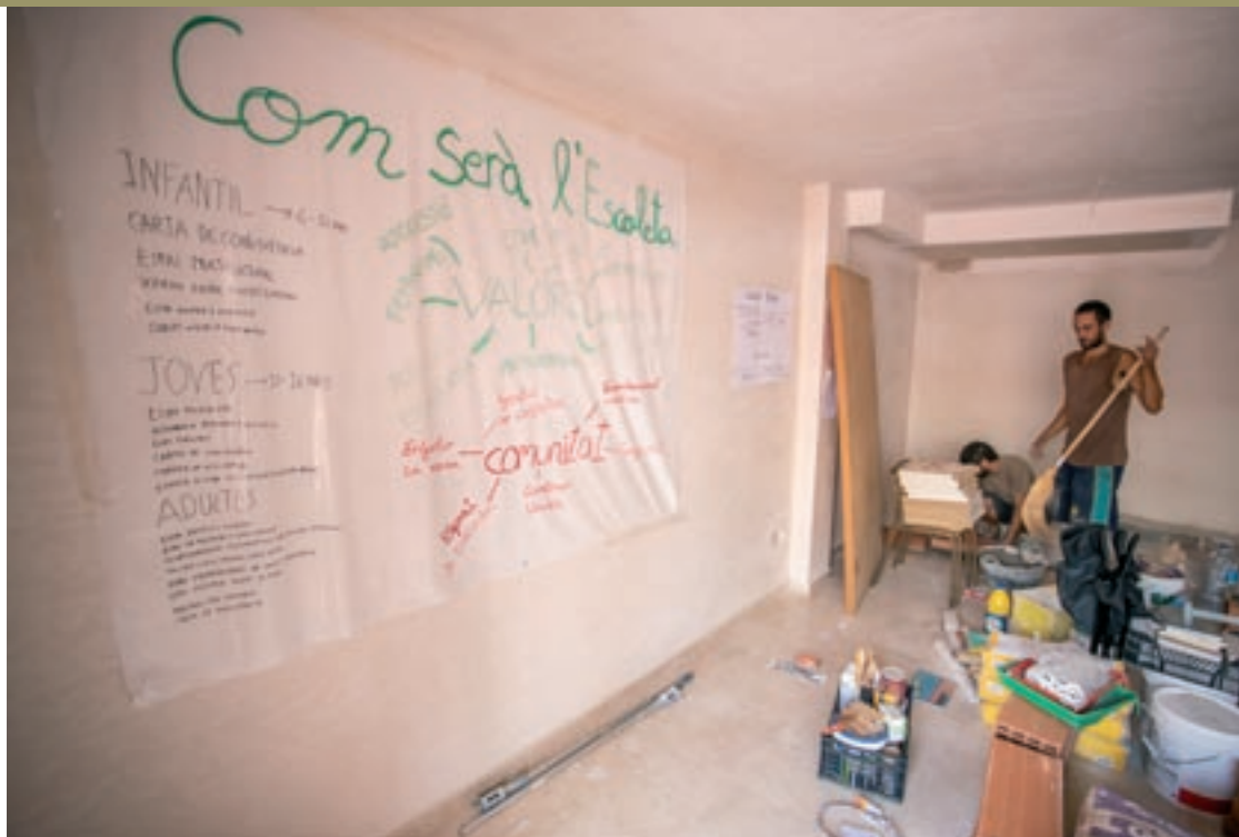
En els darrers mesos, s'ha estat treballant per donar forma al projecte en aquest espai del bloc del carrer Montserrat
