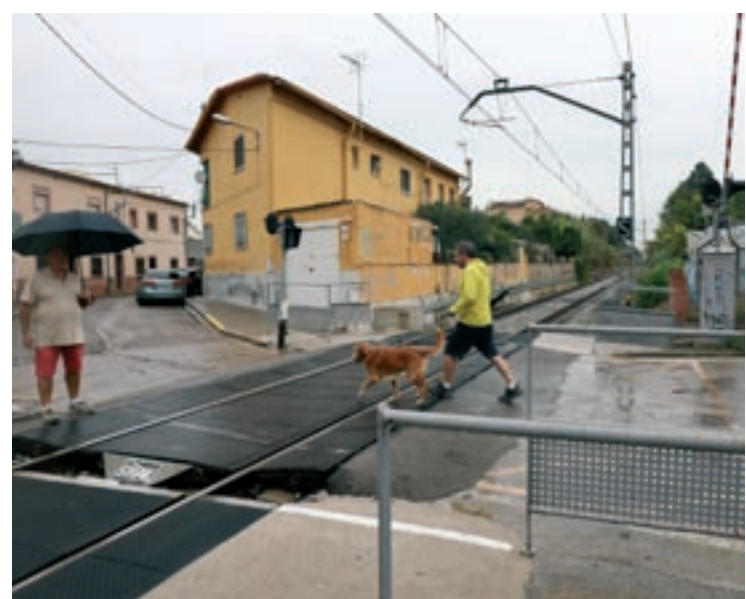
El pas a nivell que Adif preveu soterrar, aquest dijous al matí
