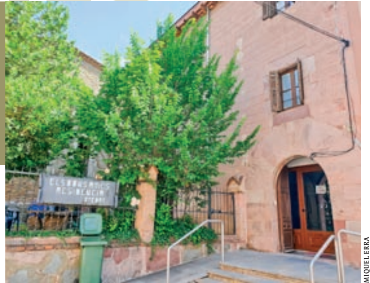
Entrada principal de la residència; la nova s'ubicarà al mateix emplaçament
