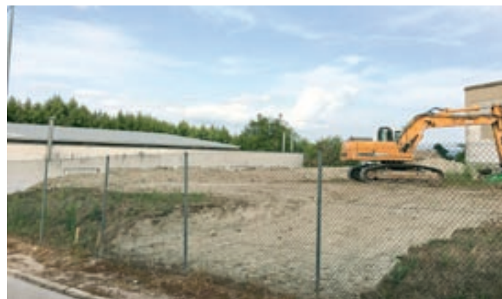
Imatge de les màquines treballant al terreny on es fa l'ampliació
