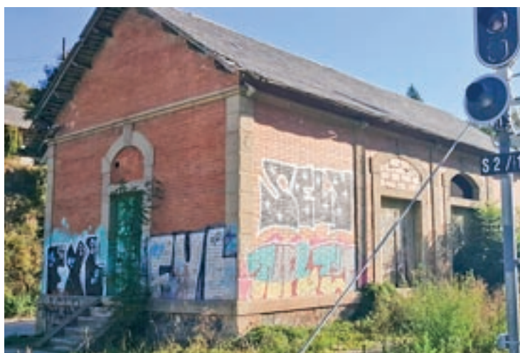
Vista de l'edifici que s'enderrocarà
