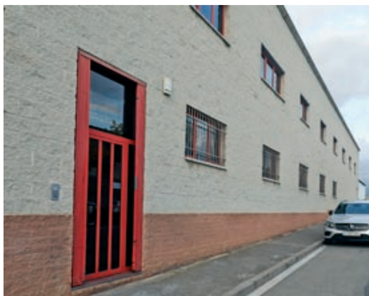
La central de Mangra, al polígon de la Coromina de Manlleu
