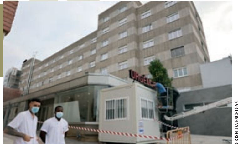
Un operari col·locava dimecres el rètol d'urgències al nou accés
