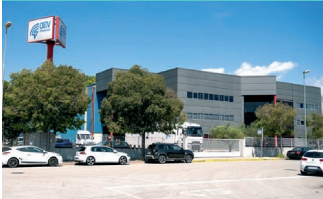
Instal·lacions de l'enginyeria QEV Technologies a Montmeló
