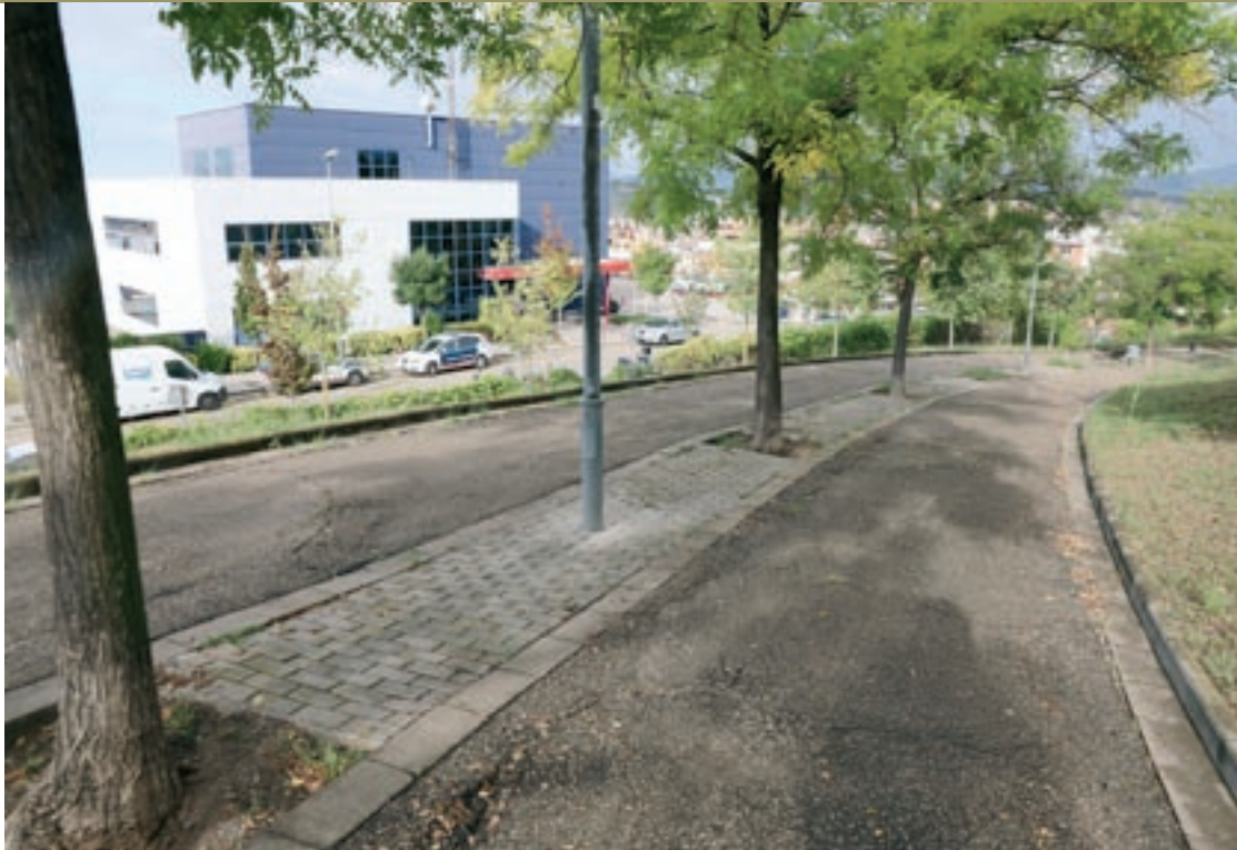
Un dels camins circulars que permeten donar la volta al parc. El projecte vol reduir l'amplada de la zona pavimentada
