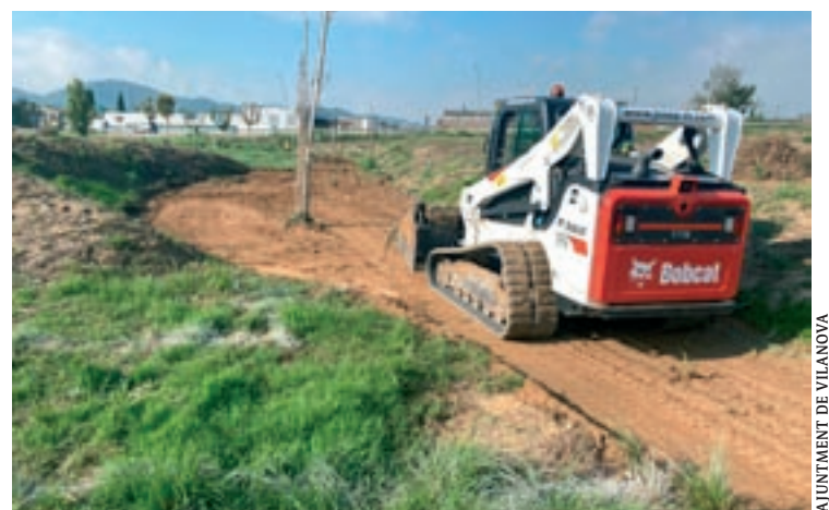
Les obres han començat aquesta setmana
