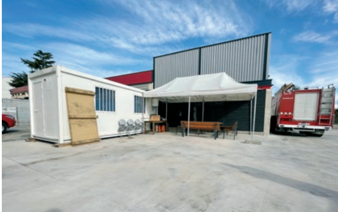
El nou edifici que amplia el parc de Bombers amb els contenidors provisionals que ara acullen la cuina dels Bombers
