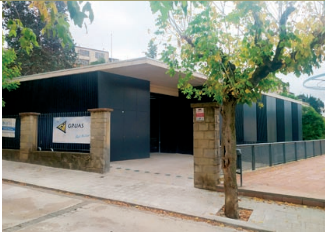
Les obres del nou CAP, al costat del centre cívic, estan molt avançades
