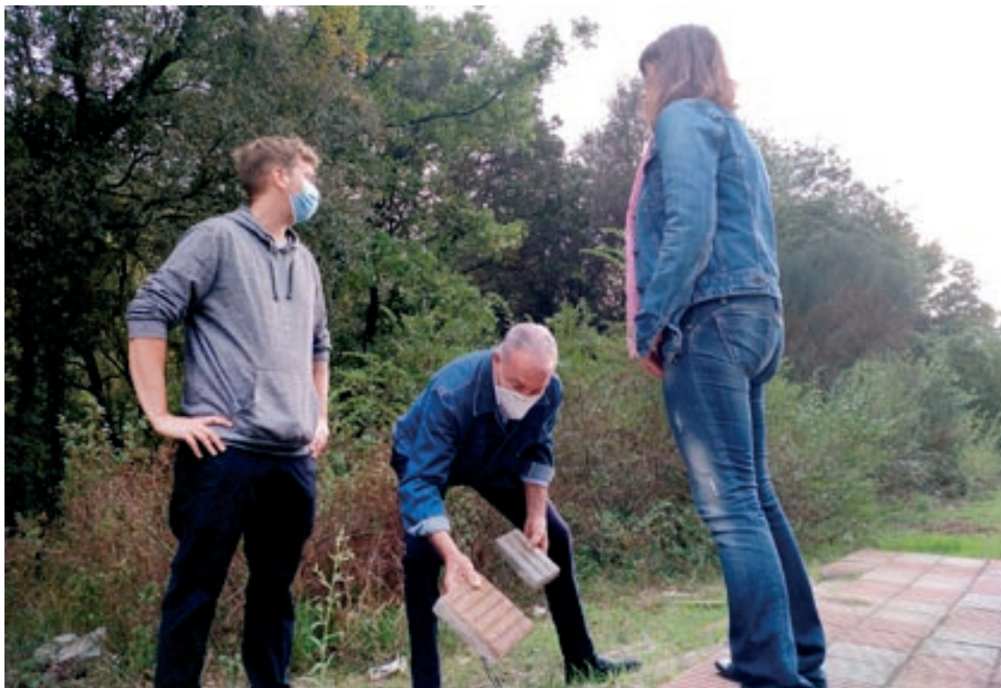
Veïns de Canadà Park mostren els desperfectes a la vorera d'un carrer
