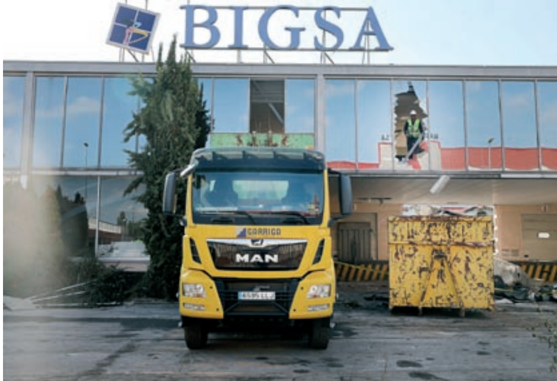
Els treballs d'enderroc de part de les naus de l'antiga Bigsa van començar fa poques setmanes
