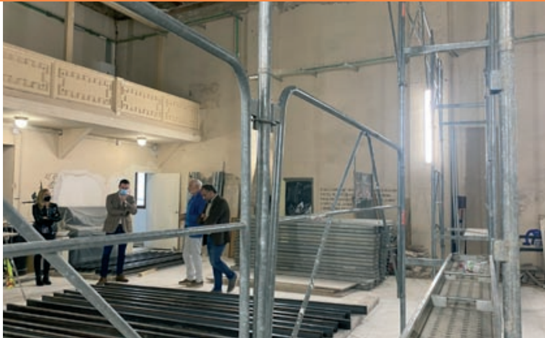
Dijous es va fer una visita a les obres de rehabilitació de l'equipament
