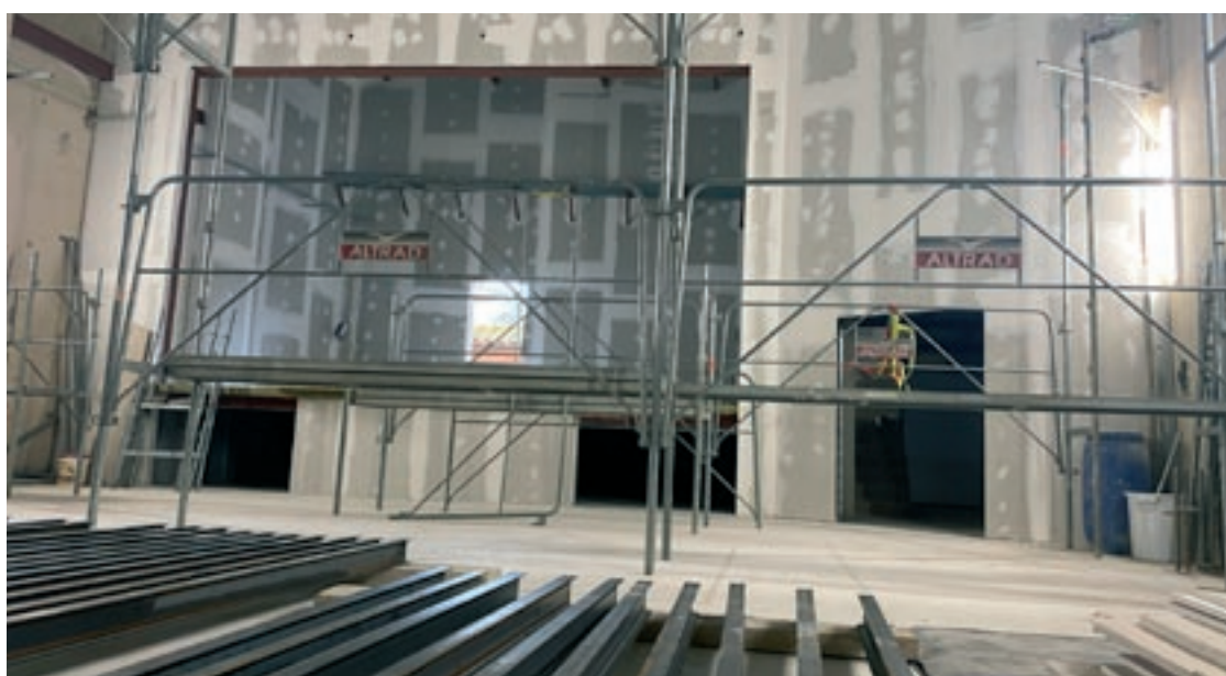
Estat actual de les obres de rehabilitació del teatre
