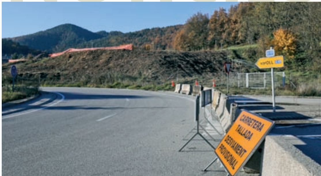
A la dreta, l'antiga C-17z tallada al trànsit des del gener de 2020; al fons, les obres del nou vial
