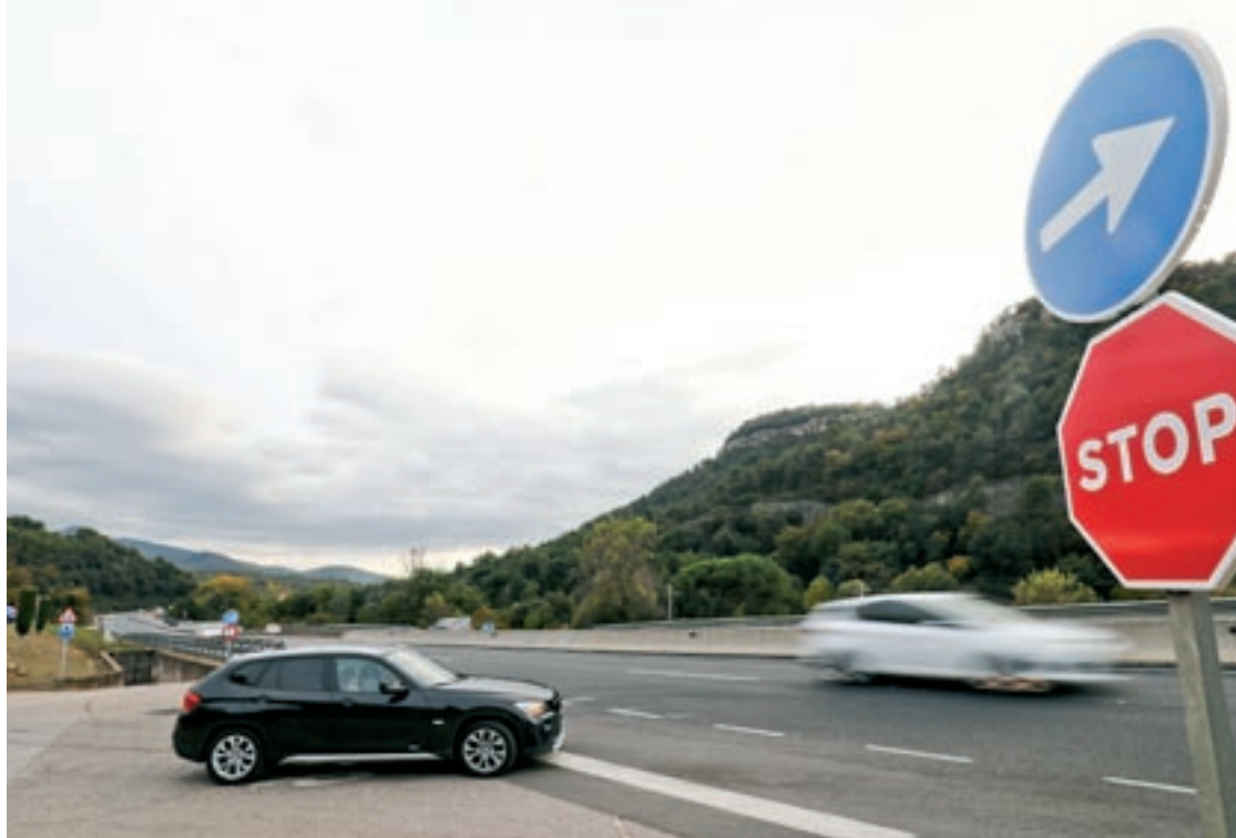
La incorporació a la calçada en sentit nord de la C-17, al costat del restaurant El Pinós, no té carril d'acceleració
