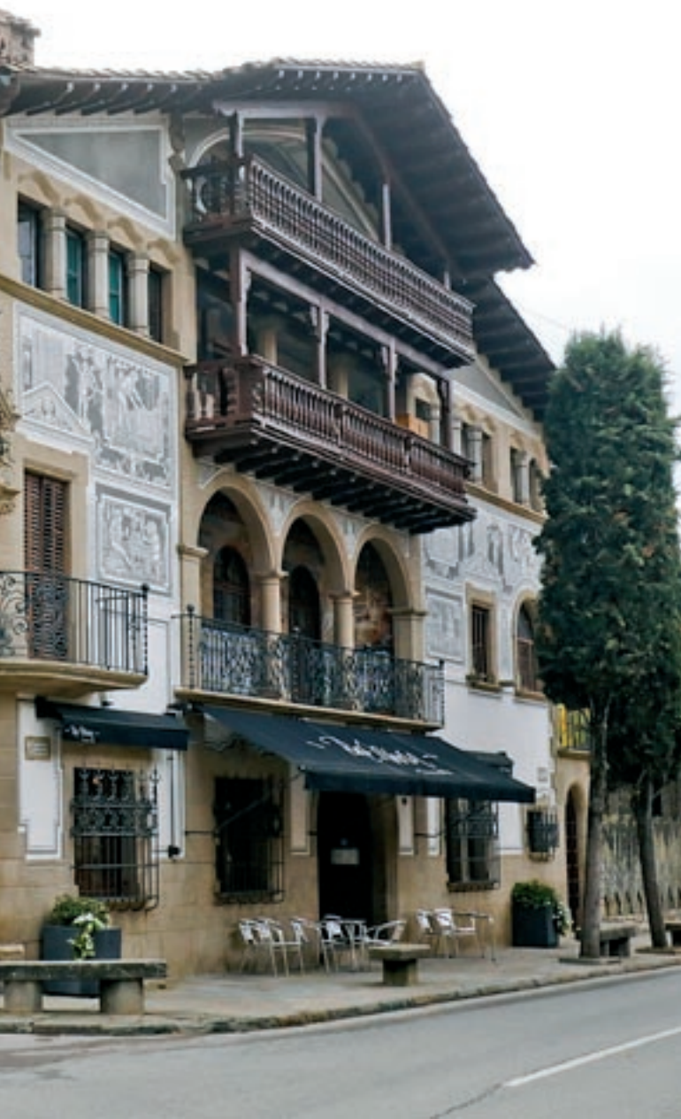
Arquitectes continuen treballant en la reforma interior dels pisos, la majoria de lloguer
