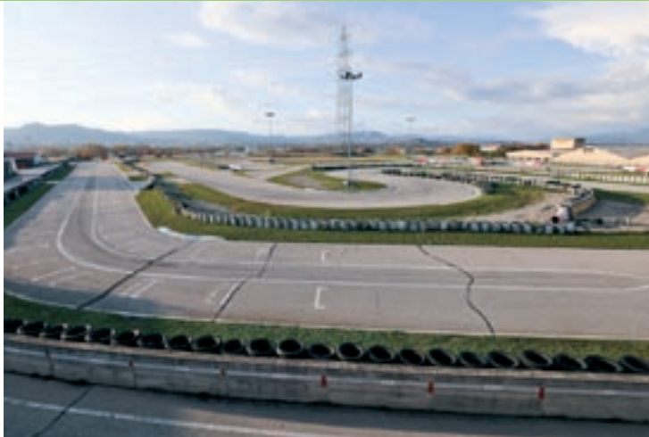
Estat actual de la pista vella, on ara s'actuarà
