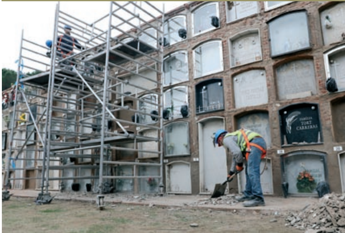
Els operaris repiquen la façana després de protegir o retirar els elements dels guarniments dels nínxols
