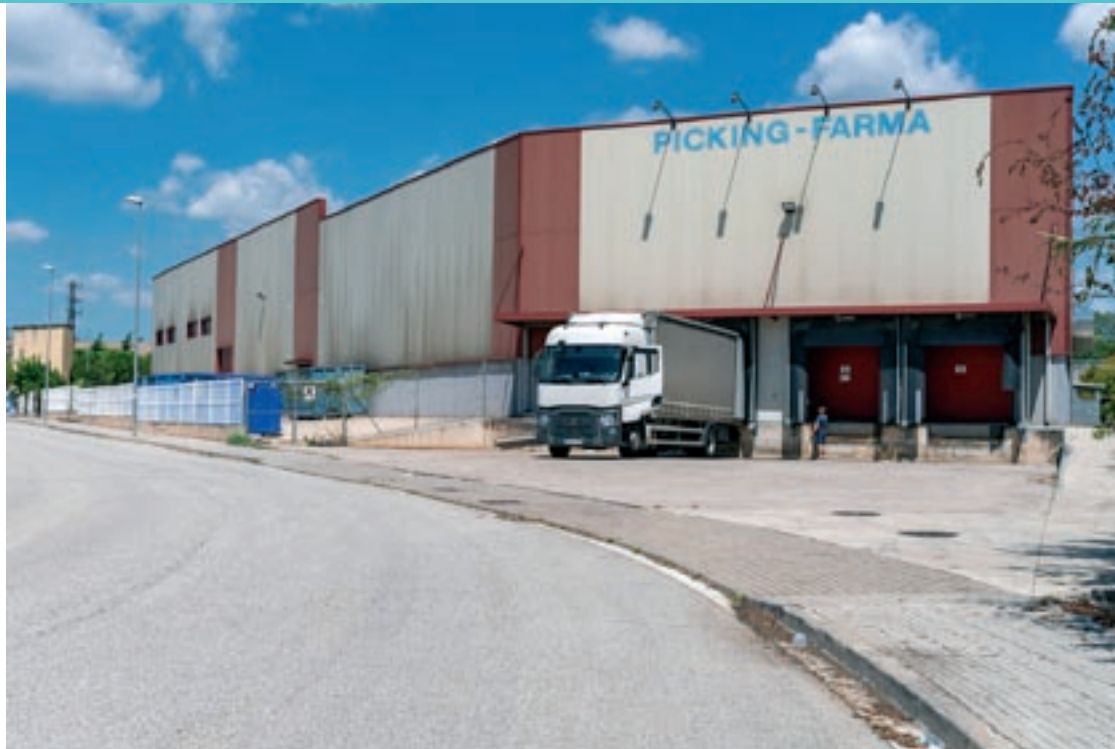
Aspecte exterior de les instal·lacions de Picking Farma a Parets, les més veteranes del grup logístic
