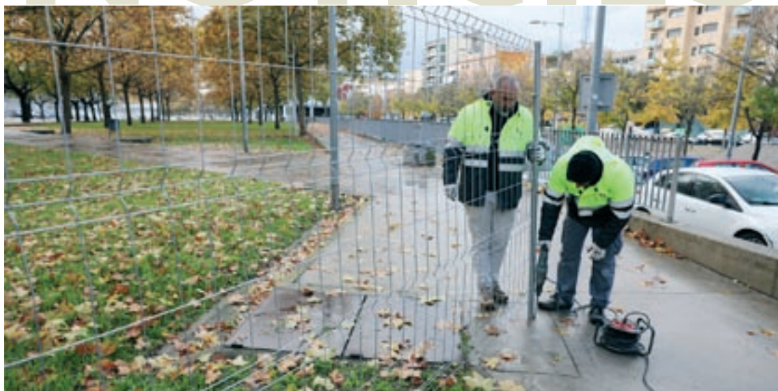
Els operaris treballaven dijous al matí per instal·lar les tanques a totes les entrades del parc de la Malagarba
