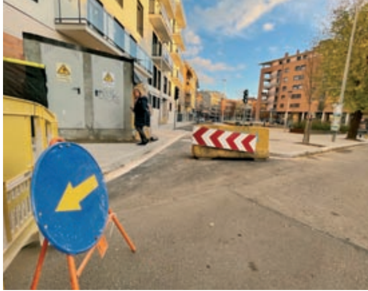
El carrer tallat amb una vianant al costat del transformador que cal demolir
