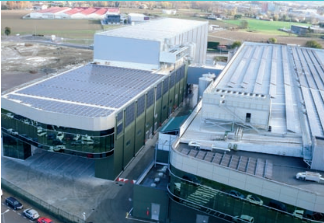
Vista aèria del nou centre logístic, ubicat al polígon Mas Galí de Gurb, amb plaques solars fotovoltaïques a les cobertes
