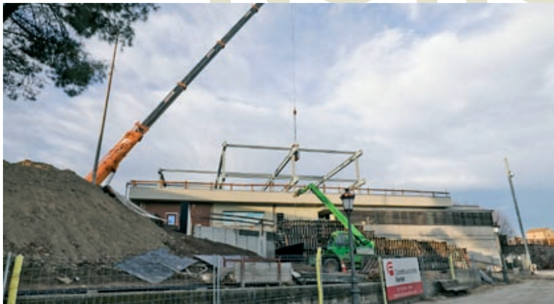
La construcció de l'edifici del nou laboratori ja ha començat
