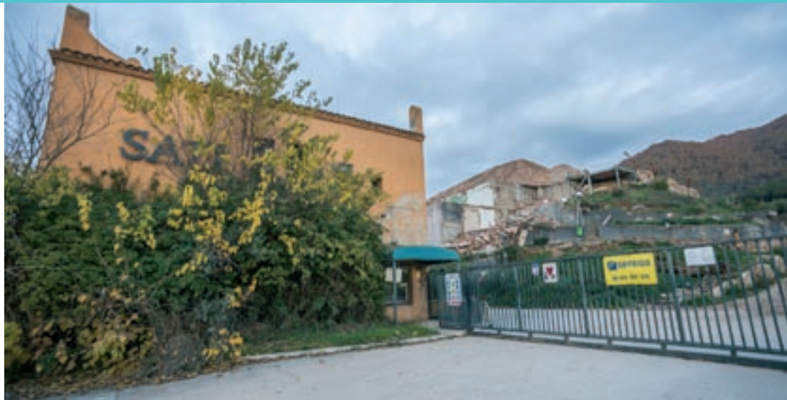
L'antic accés principal a les naus que formaven el complex industrial de la Sati, ara gairebé enderrocat del tot
