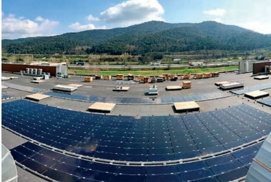
Una instal·lació industrial de SolarProfit, a la coberta de les instal·lacions de Boboli al polígon de Llinars Park
