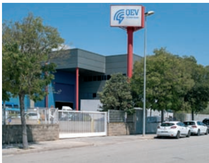
Les actuals instal·lacions de QEV a Montmeló
