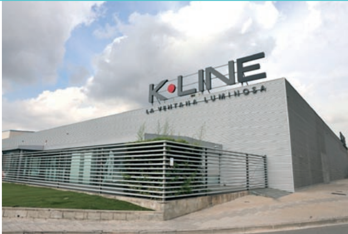
Un dels espais on s'ha fet l'ampliació d'instal·lacions de l'empresa
