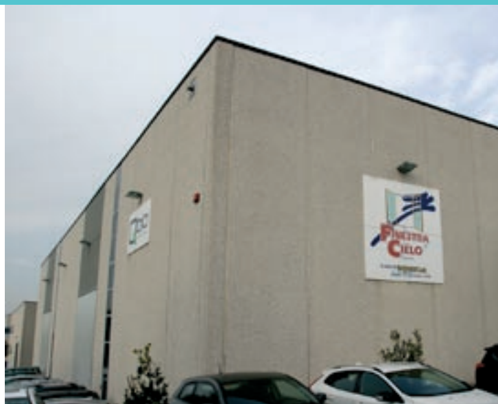
Instal·lacions de La Finestra Sul Cielo a Montmeló
