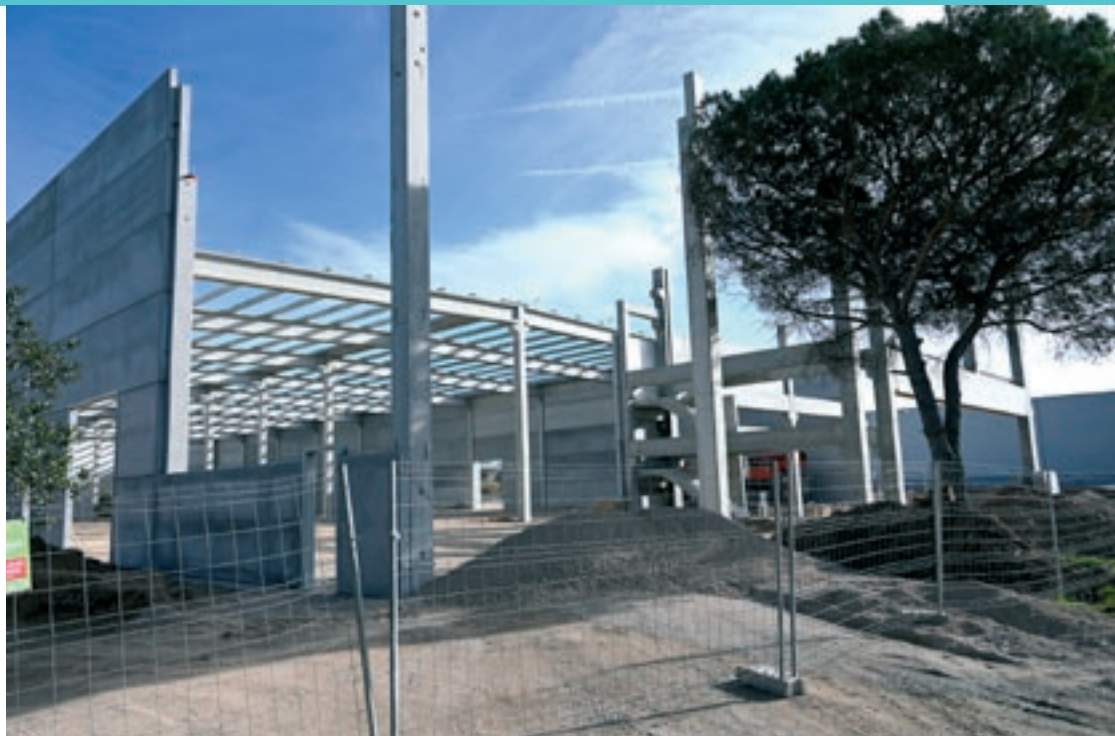
La nau que ocuparà la botiga 'on line' de material esportiu s'està construint i estarà operativa al llarg de 2022
