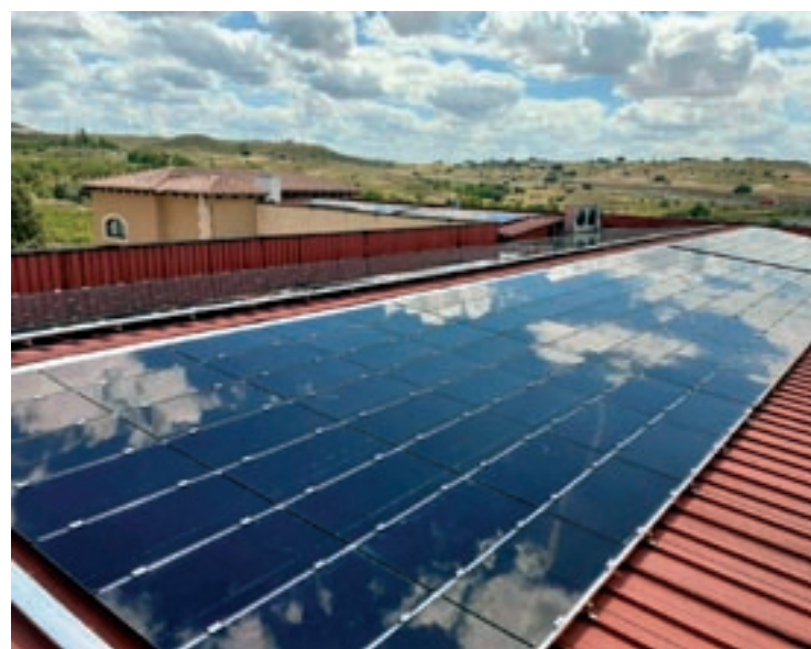
La instal·lació que SolarProfit ha fet a la bodega de Burgos
