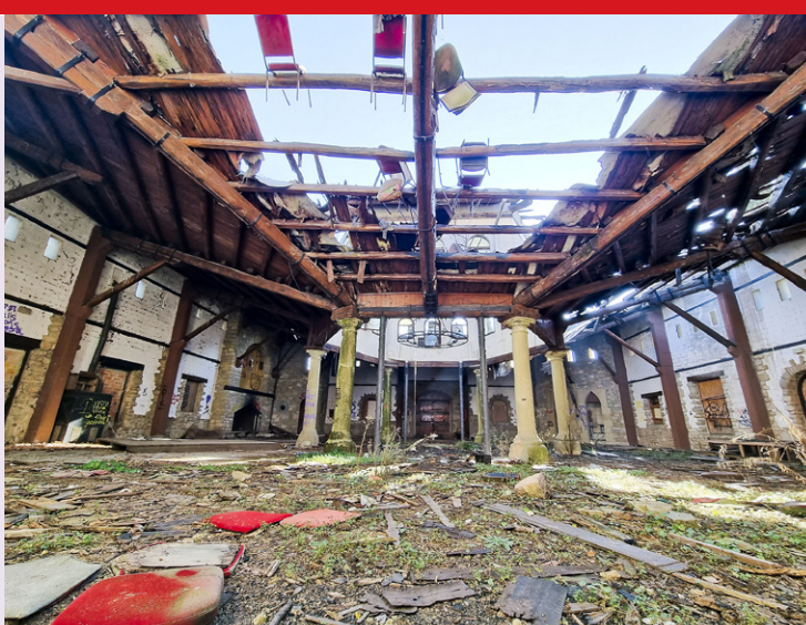
Aspecte de l'antic saló per a les celebracions, ara amb el sostre esventrat
