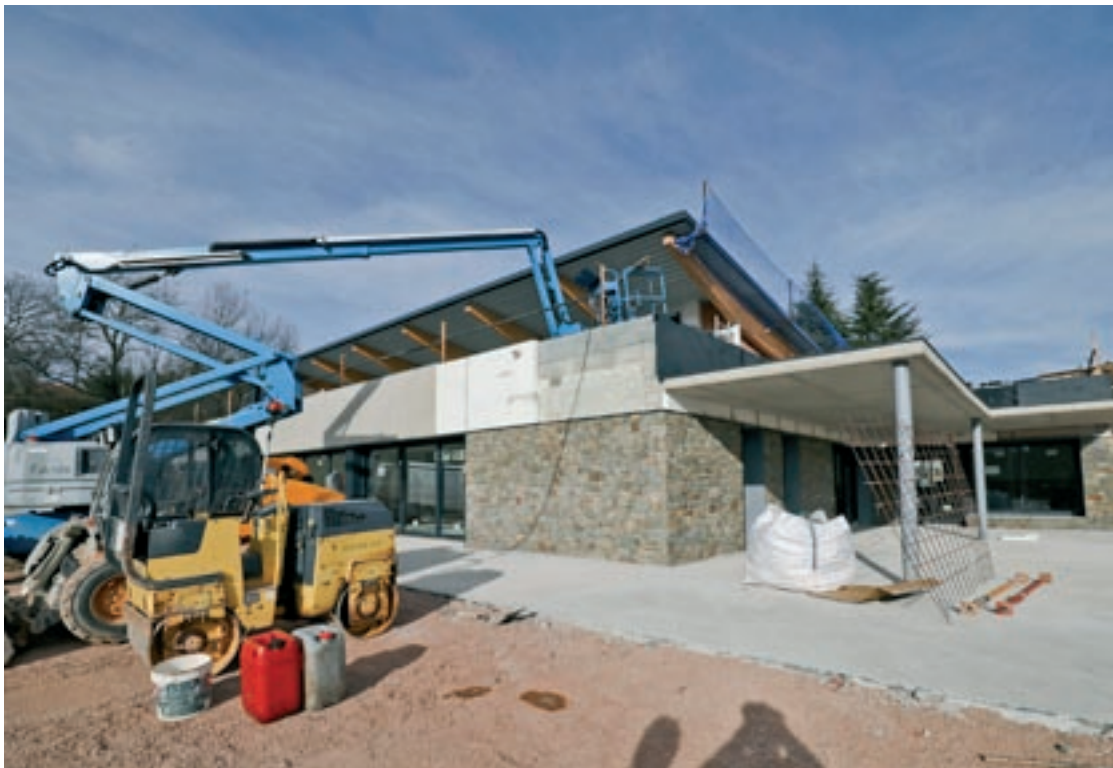
L'estat de l'edifici de l'escola de Muntanyola, encara en obres, aquest dimarts
