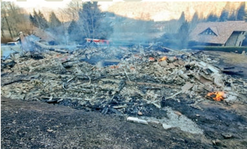
L'estat en què van quedar les cases de dues plantes un cop apagat el foc
