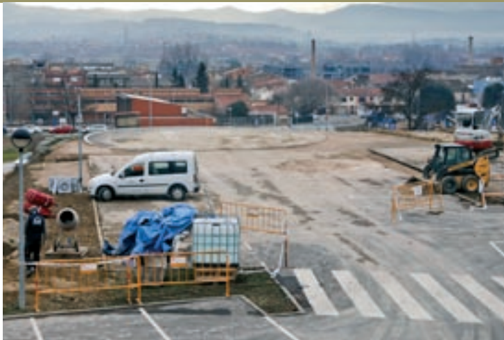
Les obres a l'helisuperfície situada al costat de l'hospital ja han començat
