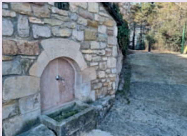
Inici del camí perimetral, desbrossat i amb una capa de sauló, vist des de la font que es va batejar amb el nom de Puig Gempí
