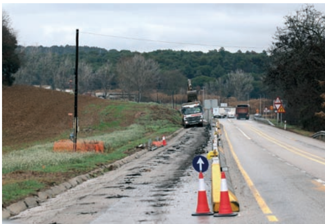
Els treballs entre la rotonda de la BV-5301 i l'accés a Can Bosch restringeixen la calçada i fan més estrets els carrils
