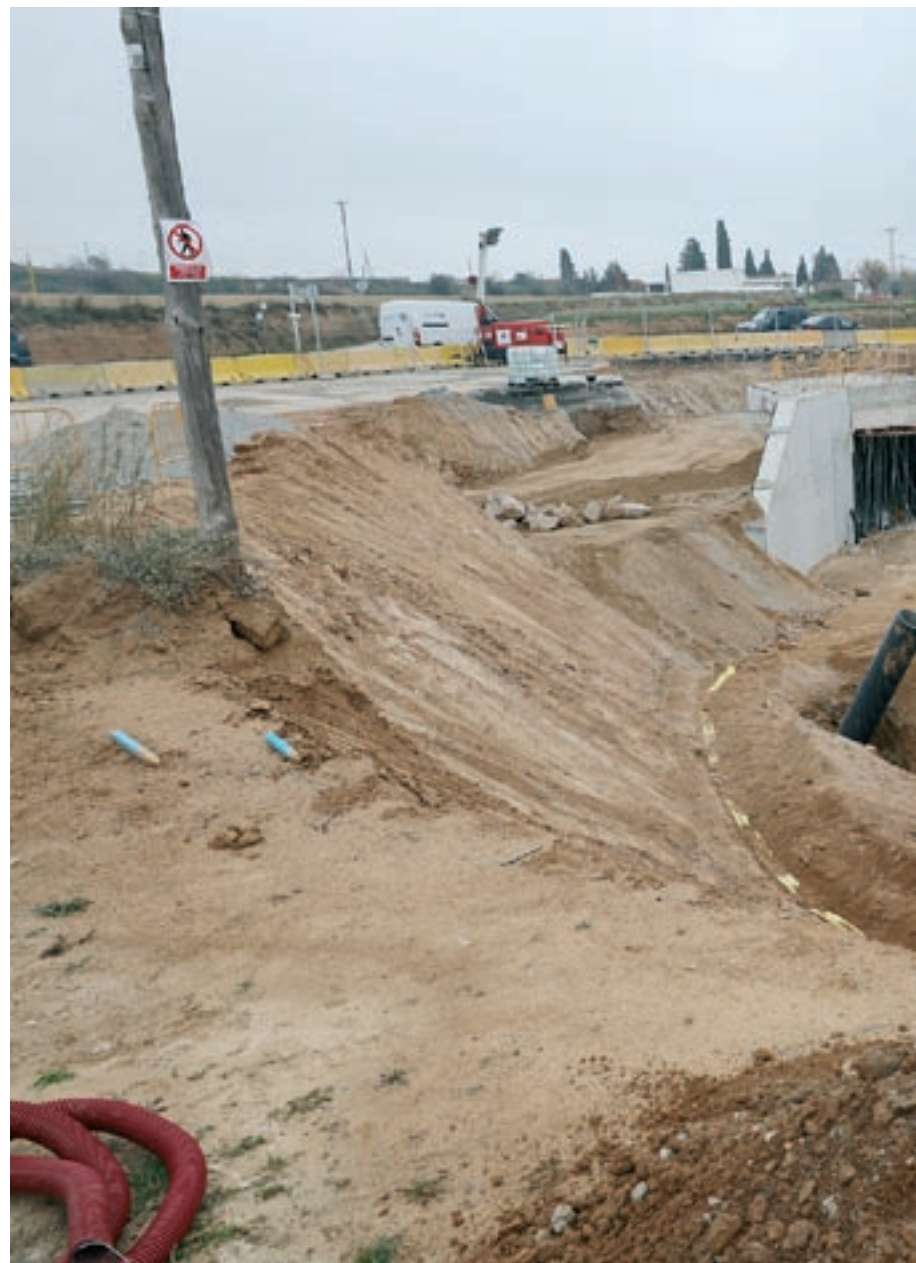
Les obres de construcció d'un pas per a vianants per travessar la C-59 a Caldes, un dels punts on
