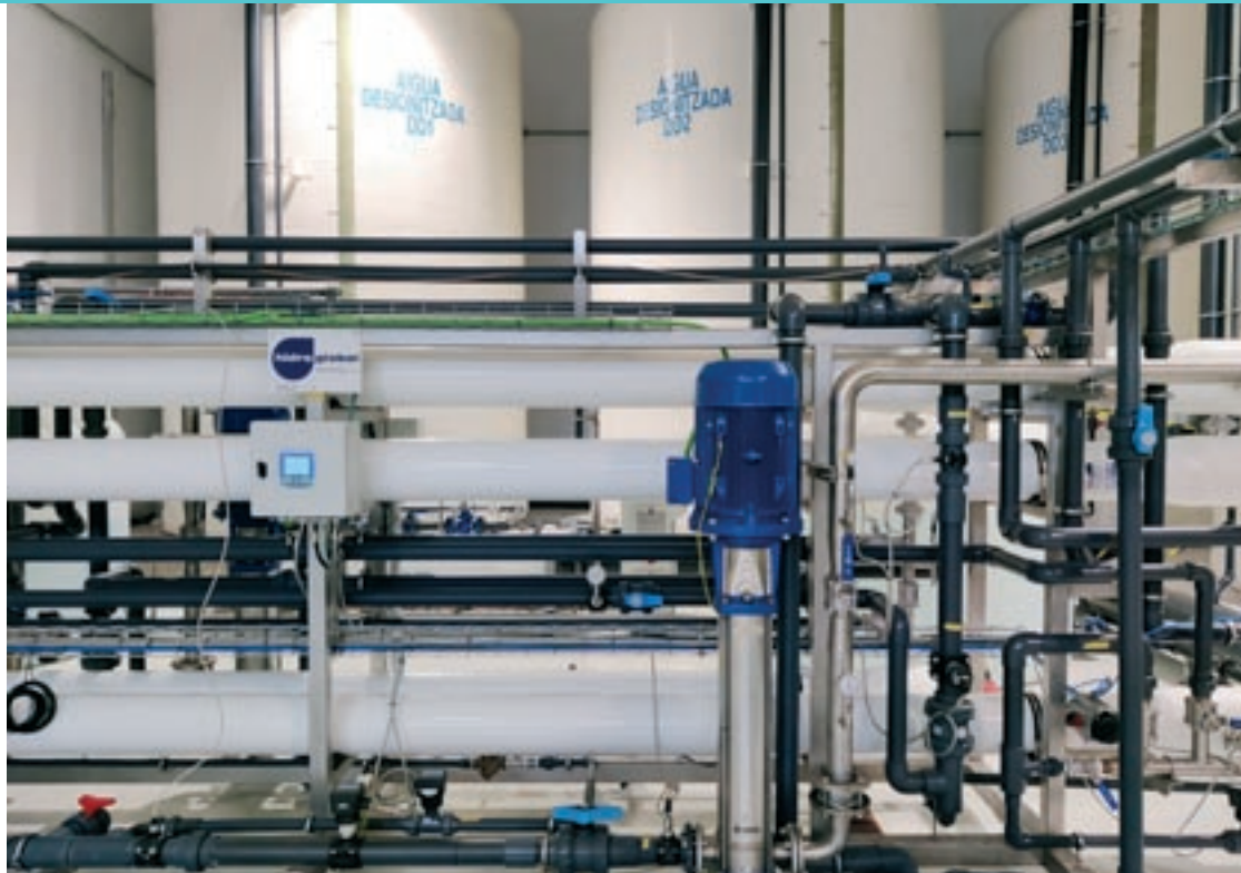
Interior de les instal·lacions de l'empresa de Granollers
