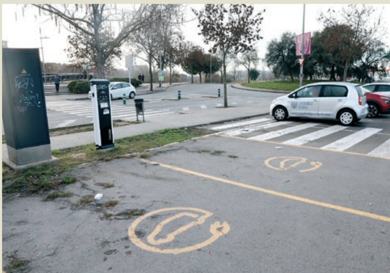
Els pilots verds als dos costats del punt de connexió indiquen que aquest ja està actiu i en funcionament per poder fer les càrregues
