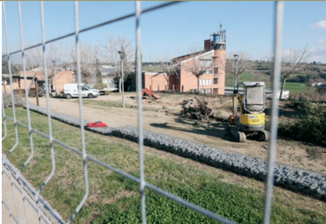
Els moviments de terres ja han començat al sector de l'eix cívic de la Torreta
