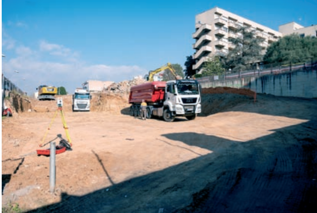
Els moviments de terres a la parcel·la on s'aixecarà el futur equipament sanitari ja són visibles des del carrer
