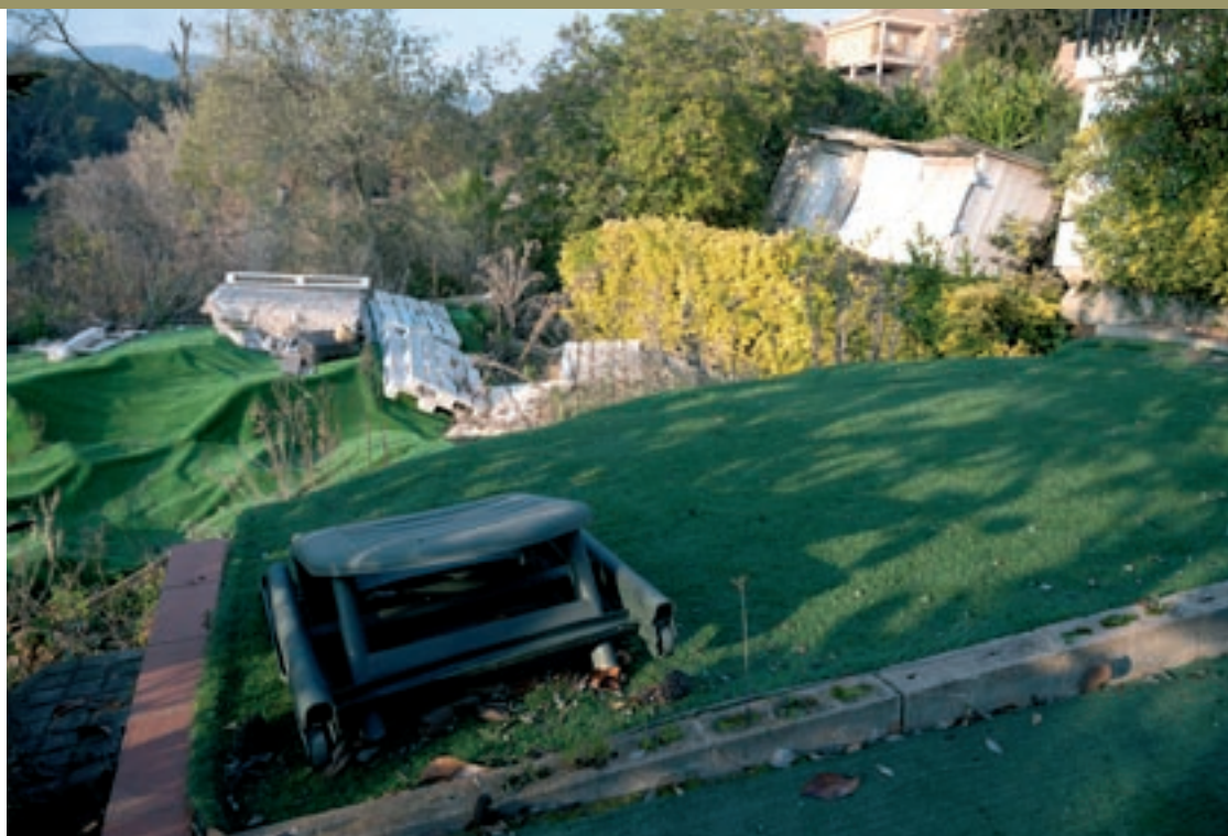
Les ondulacions del terreny que va deixar l'ensorrament del marge de la muntanya que va arrossegar les cases
