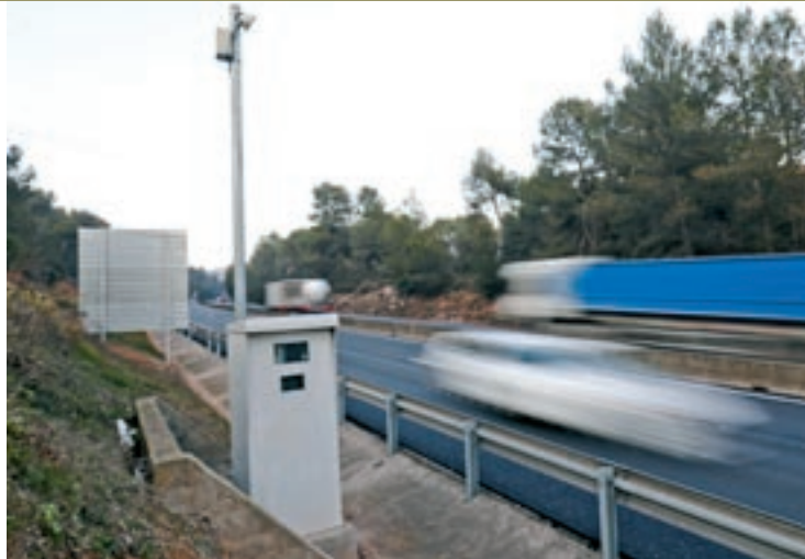
El radar fix a la calçada en sentit sud ha multiplicat per 30 les multes posades
