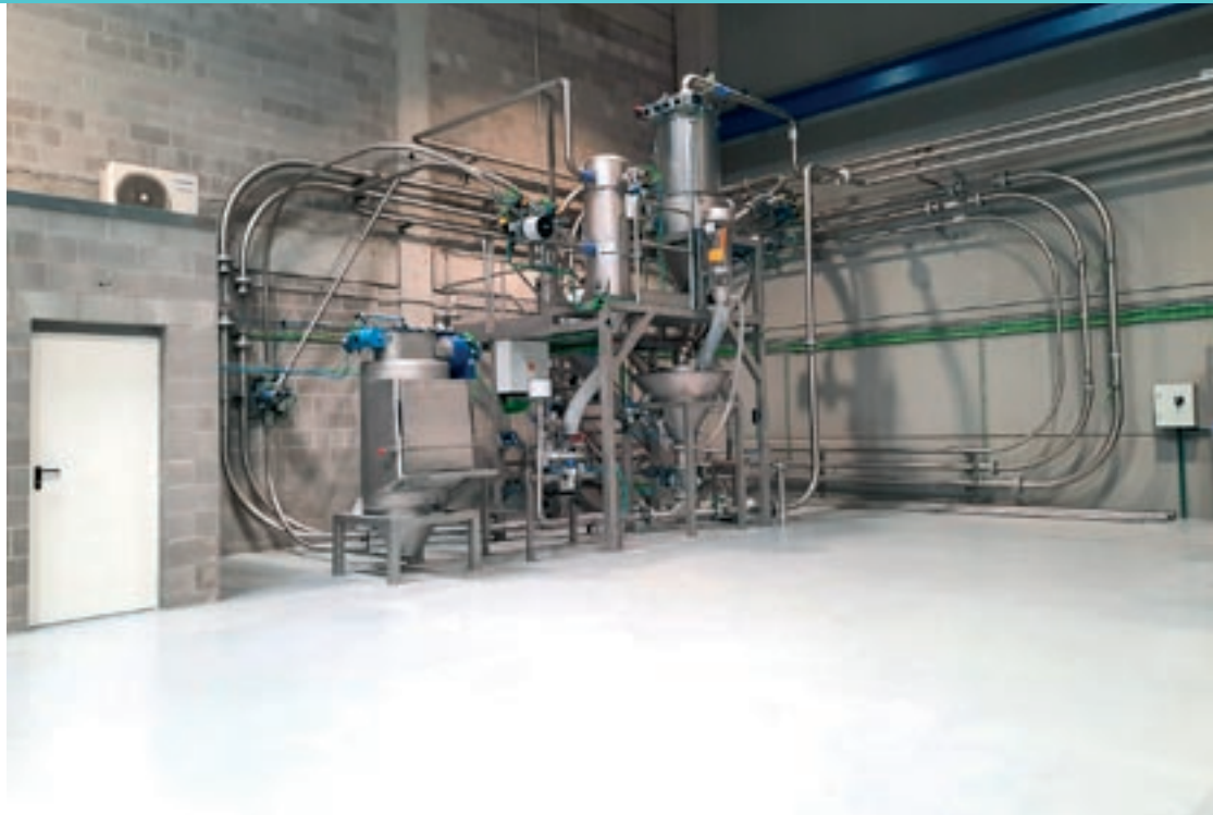
La planta pilot que la companyia ha instal·lat a les Franqueses
