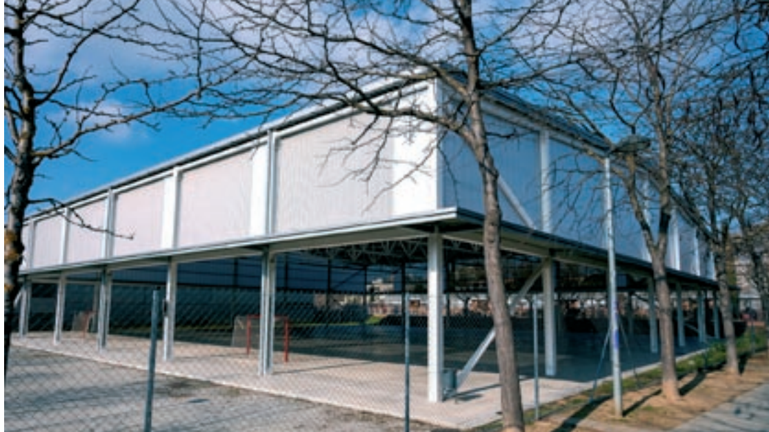
La coberta de les pistes de Can Bassa on es vol muntar una instal·lació fotovoltaica per a la producció d'electricitat
