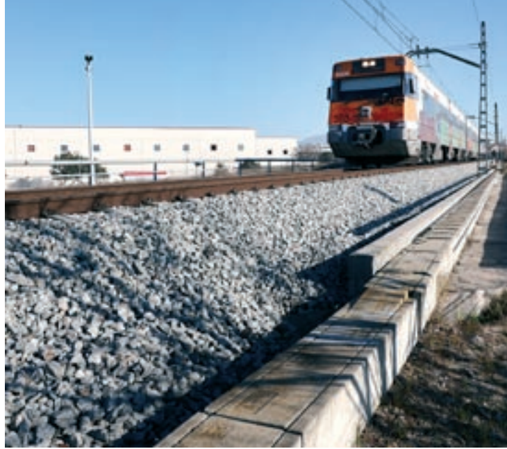
Damunt de la C-352, a les Franqueses, es farà un nou viaducte de via única
